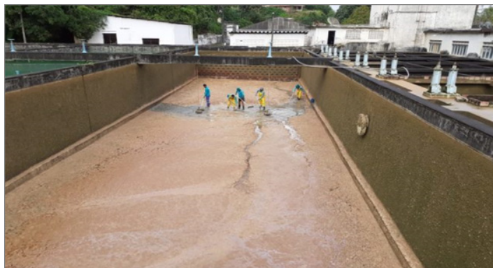
Figura 3. Lodo de ETA no Tanque de Decantação de uma Estação de Tratamento de Água
